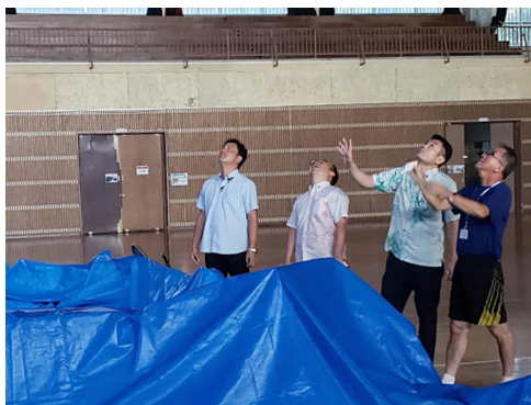
総合体育館の被害を確認
