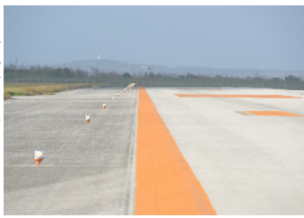
新設された照明
